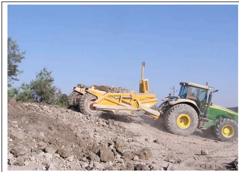
Trabajos de excavación de la charca
