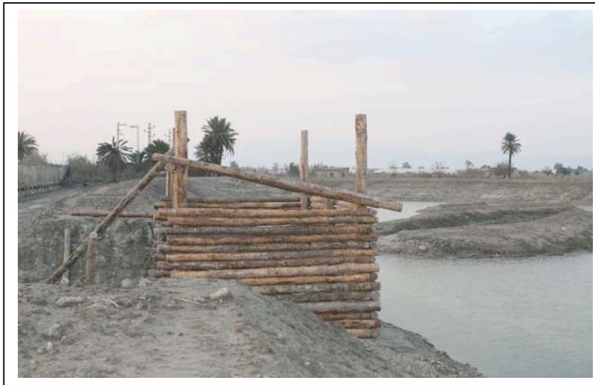
Construcción del observatorio
